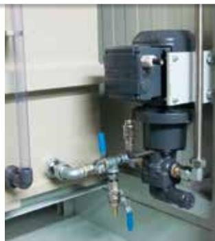
Bindemitteldosierung mit Balgdosiergerät BDG oder Zahnradpumpe mit Durchflussmesser Binder dosing with bellow dosing device BDG or geared pump with flow meter
